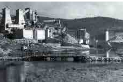
Výstavba hráze Lipno I (1952–1959).
