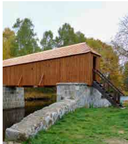
Lenora – zrekonstruovaná rechle.
